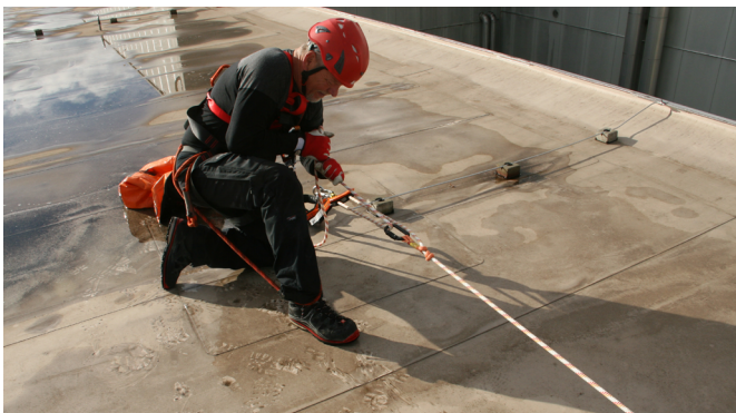
Abb. 10: Temporäres Seilsystem (Life-Line) mit Karabinerhaken an EAE befestigt
