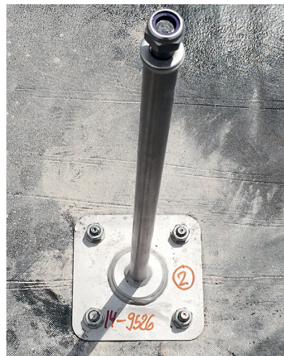
Abb. 42: Stütze fertig montiert und für die Montagedokumentation nummeriert (Objektnummer und Stützennummer, alle Befestigungen sichtbar)
