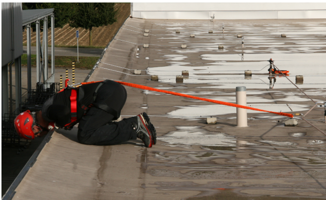
Abb. 9: Arbeiten mit Rückhaltesystem an temporärem Seilsystem
