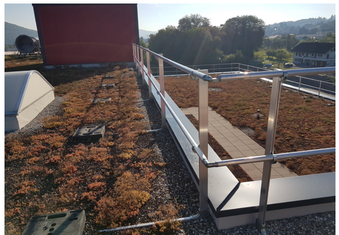
Abb. 23 Ausstattungsstufe 3: Seitenschutzsystem mit Auflast
