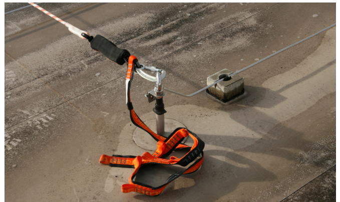
Abb. 12: In temporärem Seilsystem (Life-Line) eingebauter Falldämpfer zur Begrenzung der Kräfte auf die Anschlagseinrichtung
