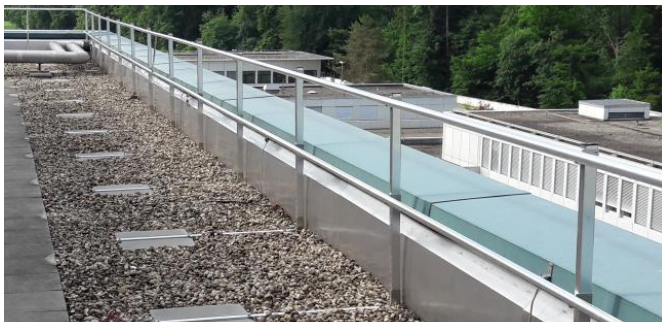
Abb. 24 Ausstattungsstufe 3: Seitenschutzsystem mit Auflast bodeneben montiert
