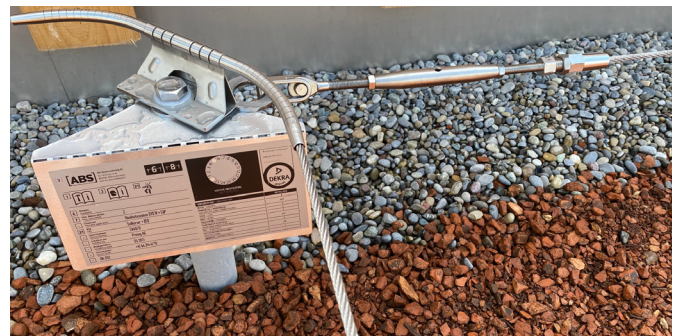
Abb. 44: Objektspezifische Kennzeichnung einer Seilanlage
