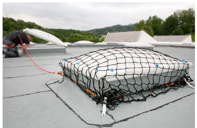
Abb. 40: Temporäre Lichtkuppelsicherung (Nur für Massaufnahme und Montage Kollektivschutz, nicht für regelmässige Instandhaltungsarbeiten)
