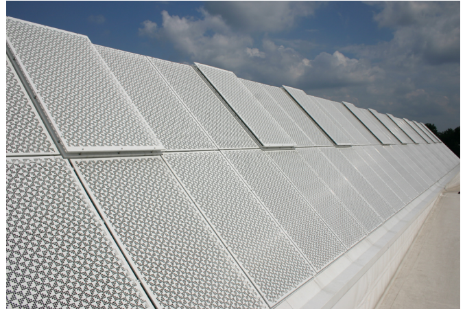
Abb. 39: Durchbruchssichere Bauteile
