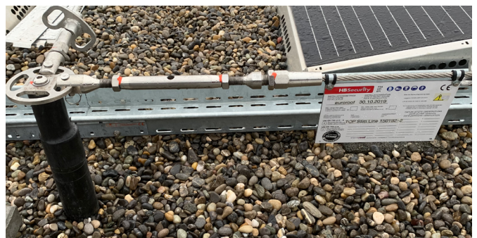
Abb. 43: Objektspezifische Kennzeichnung einer Seilanlage
