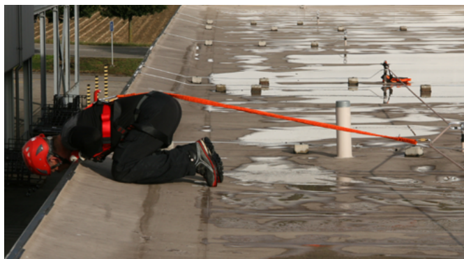
Fig. 9: Lavoro con il sistema di ritenuta su un sistema di cavi temporanei
