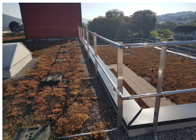
Fig. 23 Classe di allestimento 3: Sistema di protezione laterale con zavorra
