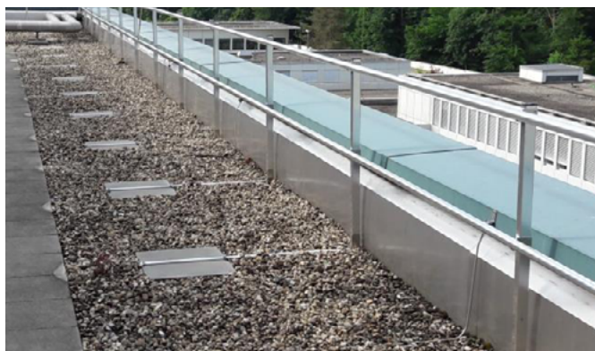
Fig. 24 Classe di allestimento 3: sistema di protezione laterale con zavorra montata a filo pavimento
