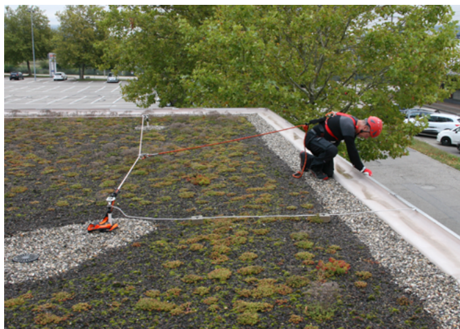
Fig. 3: Dispositivo anticaduta di tipo guidato su una guida mobile come mezzo di collegamento al dispositivo di ancoraggio, regolato
