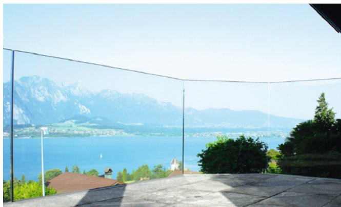
Fig. 26: Classe di allestimento 4 per le aree del tetto accessibili al pubblico.
