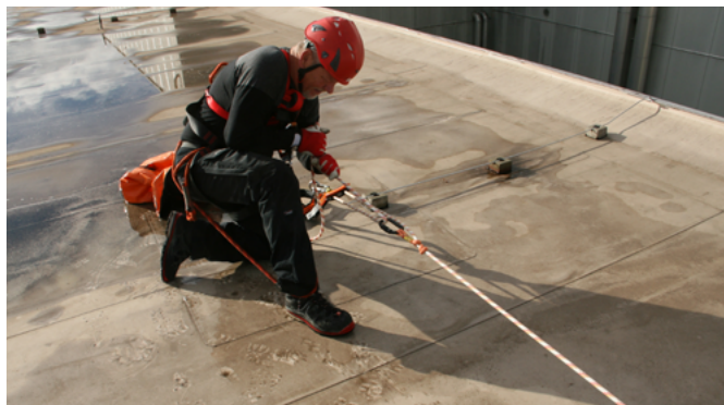
Fig. 10: Sistema di funi temporanee (Life-Line) fissato al PAS con moschettoni
