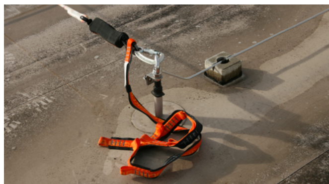
Fig. 12: Assorbitore di energia installato nel sistema di cavi temporanei (Life-Line) per limitare le forze sui dispositivi di ancoraggio
