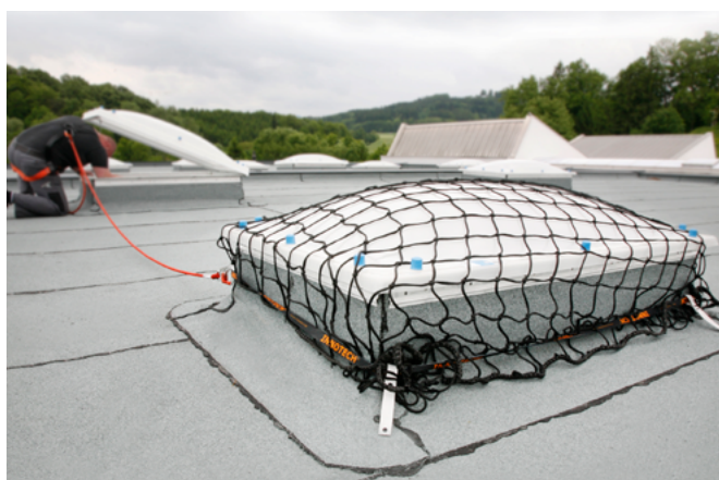
Fig. 41: Dispositivo di sicurezza temporaneo della cupola
