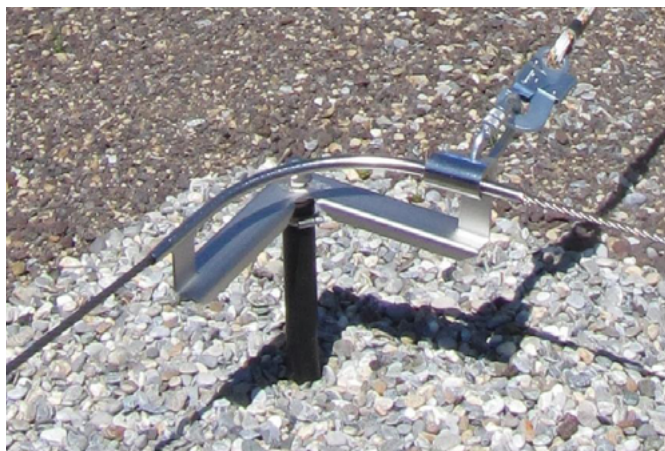
Fig. 17: Punto d'angolo liberamente percorribile secondo le specifiche del produttore
