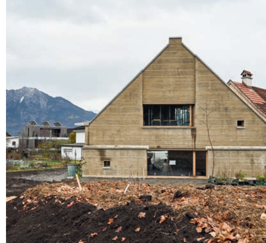
Les matériaux de construction issus de matières premières renouvelables génèrent nettement moins d'émissions de gaz à effet de serre. Cette photo montre une construction en terre crue à Grabs, dans le canton de Saint-Gall. Photo: Mike Staub
