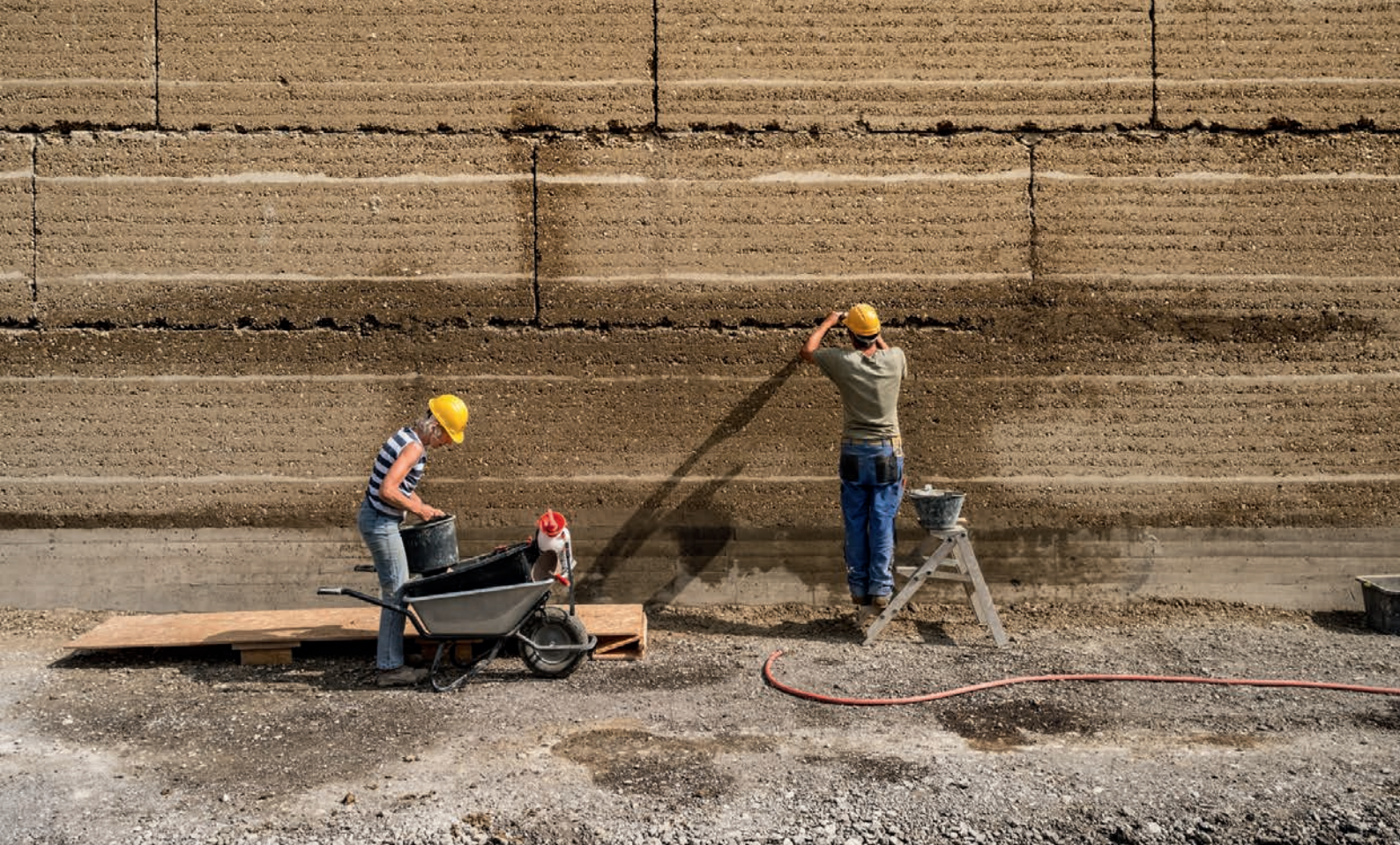
Centre des herbes Ricola, architecture : Herzog & de Meuron, construction en terre crue : Lehm Ton Erde Baukunst. Photo : Markus Bühler-Rasom, Ricola AG
