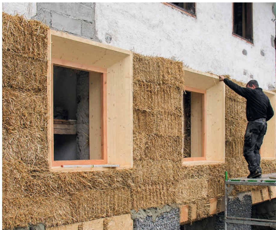
Cette photo montre le projet «Casa Steila Mar» ou maison «P&W» à Susch, dont la façade extérieure a fait l'objet d'une rénovation thermique à base de paille. Photo: Atelier Schmidt
