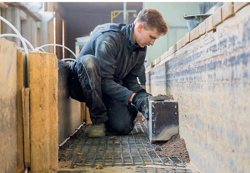
Cette photo montre le processus de préfabrication du pisé. Photo: Emmanuel Dorsaz
